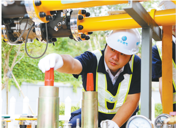
济华燃气的工人对燃气管网和附属设施进行安全巡检。
