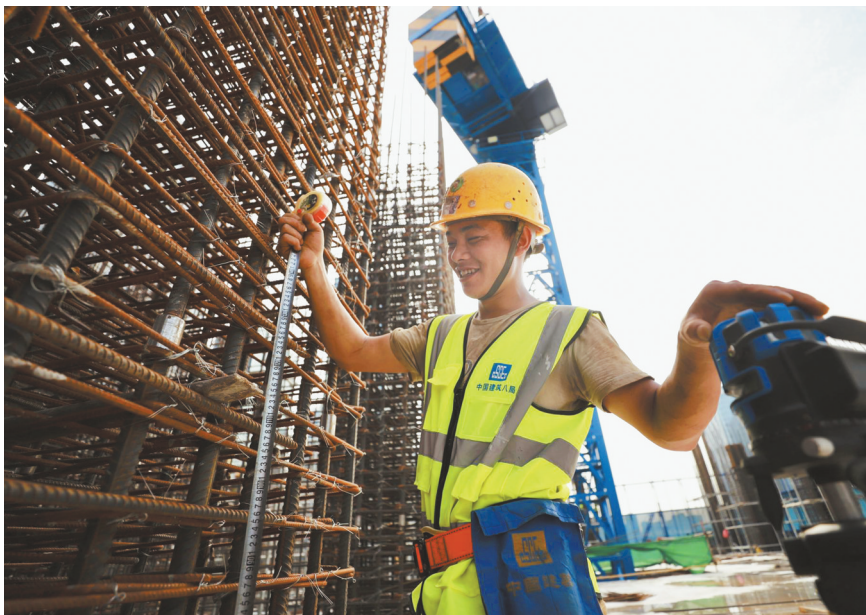
中建八局的建筑工人们为城市建设增砖添瓦。
