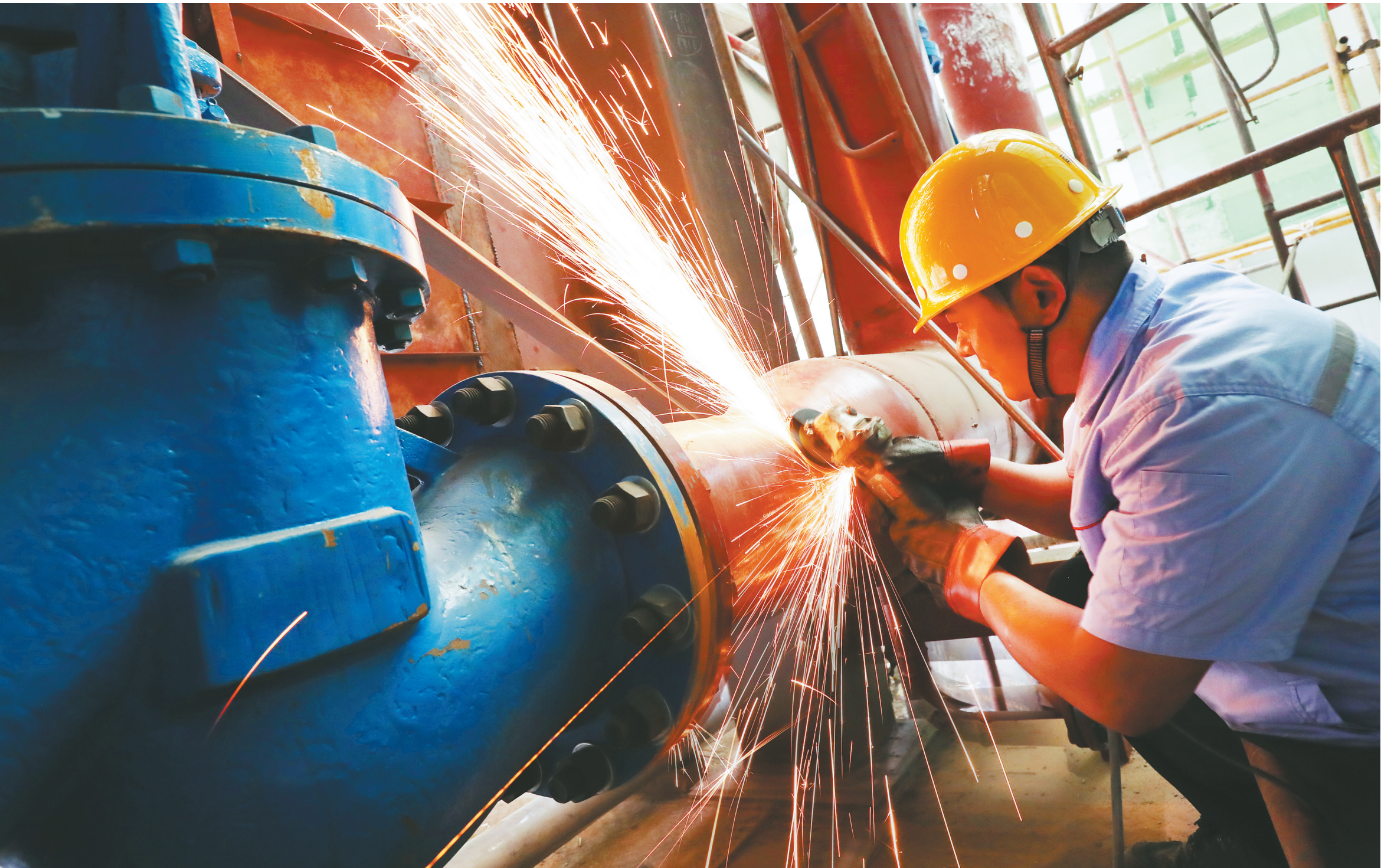
济南热电的工人在新能源锅炉前作业,力争早日让设备投入运行。
