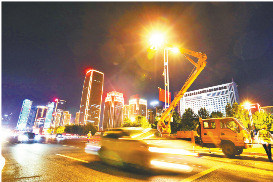
夜幕下,城市照明公司的工人坚守在岗。
