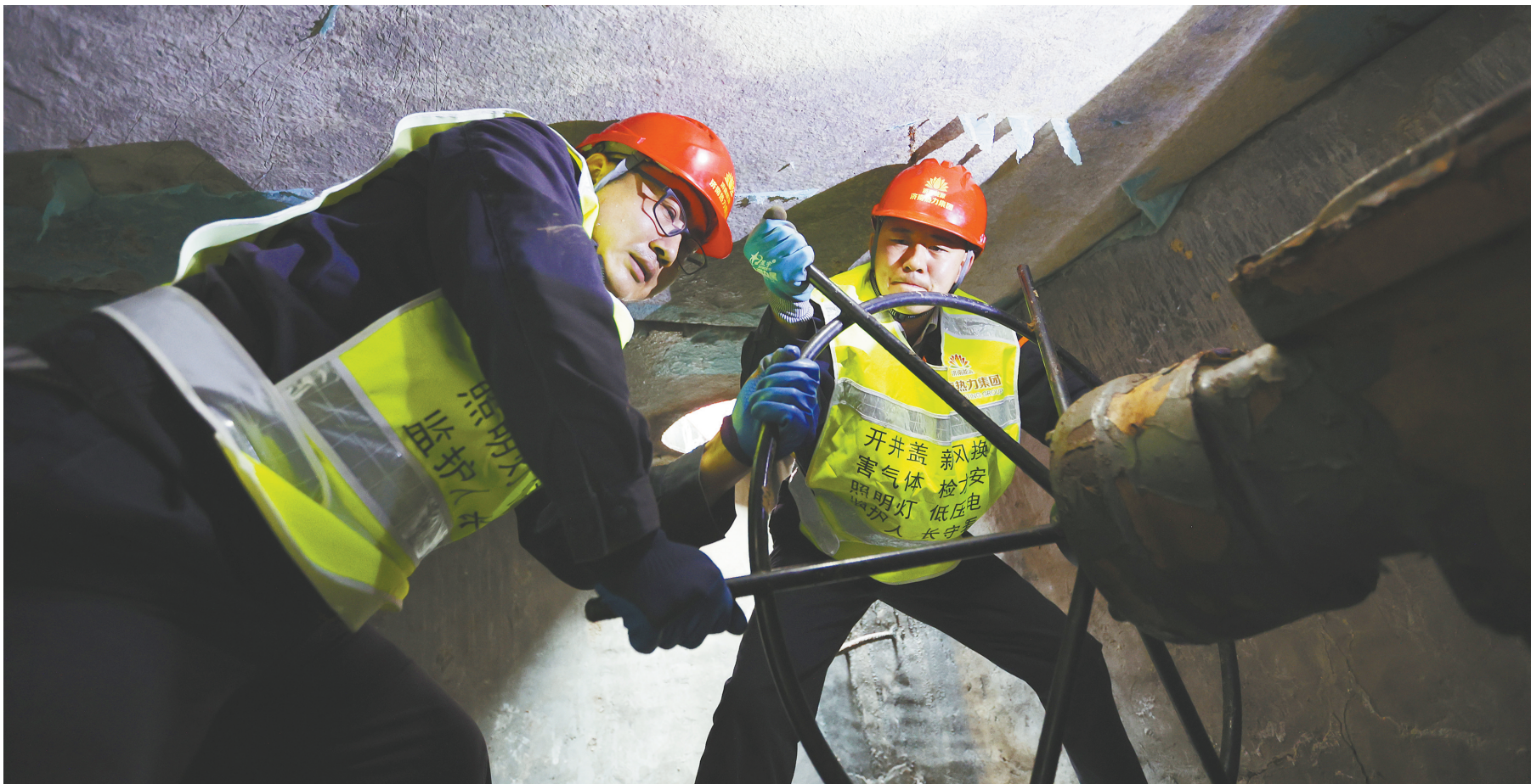
济南热力的工人们仍坚守岗位,全力以赴做好供热运行准备工作。
