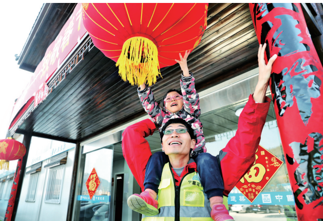
中建八局的开元寺入口景观提升项目上张灯结彩,大年三十坚守岗位的张浩正与女儿一起挂灯笼。
